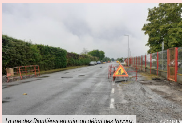
La rue des Riantières en juin, au début des travaux.
